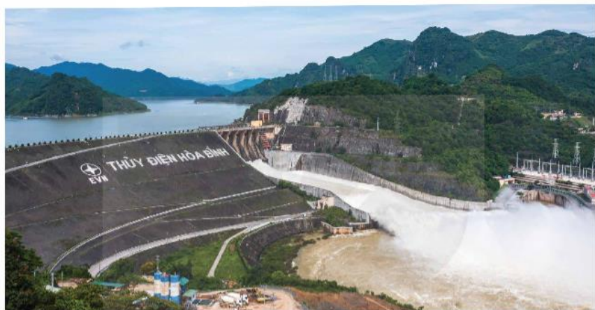
Hình 17.5 Nhà máy thủy điện Hoà Bình
